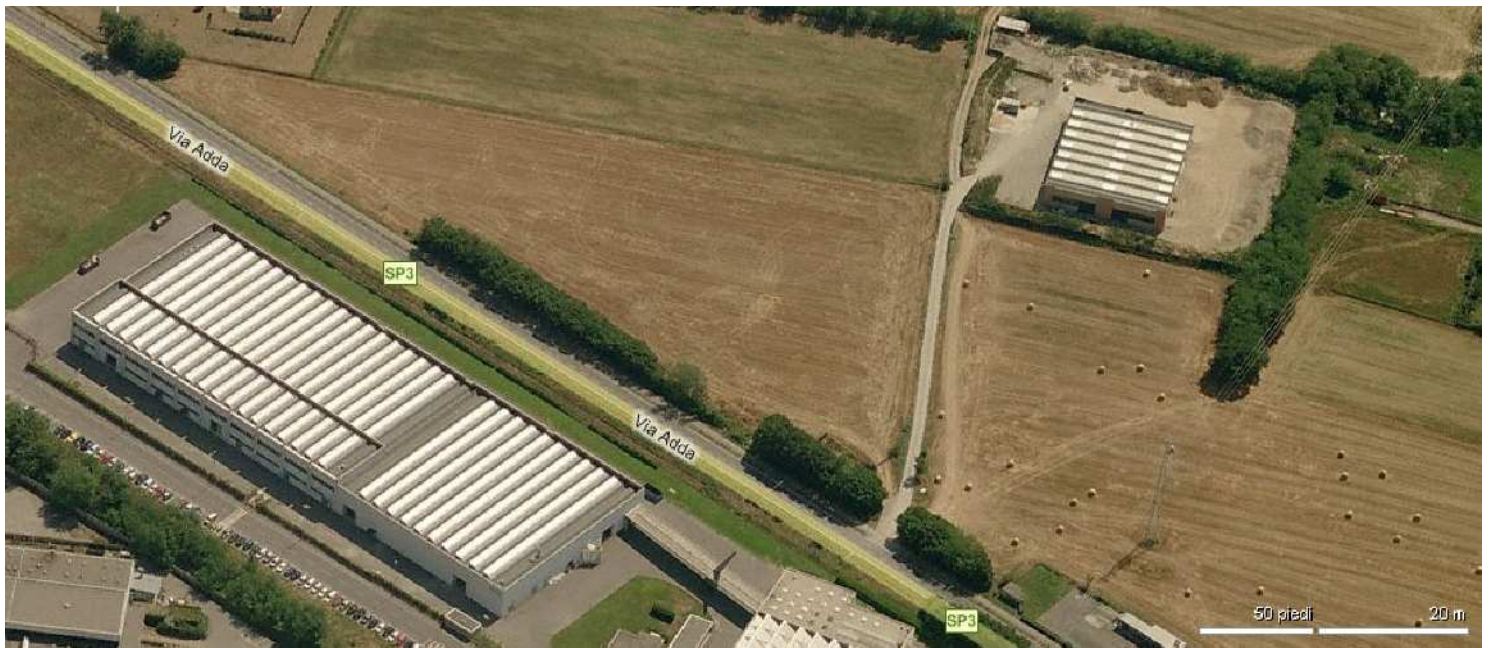
vista da ovest verso est
