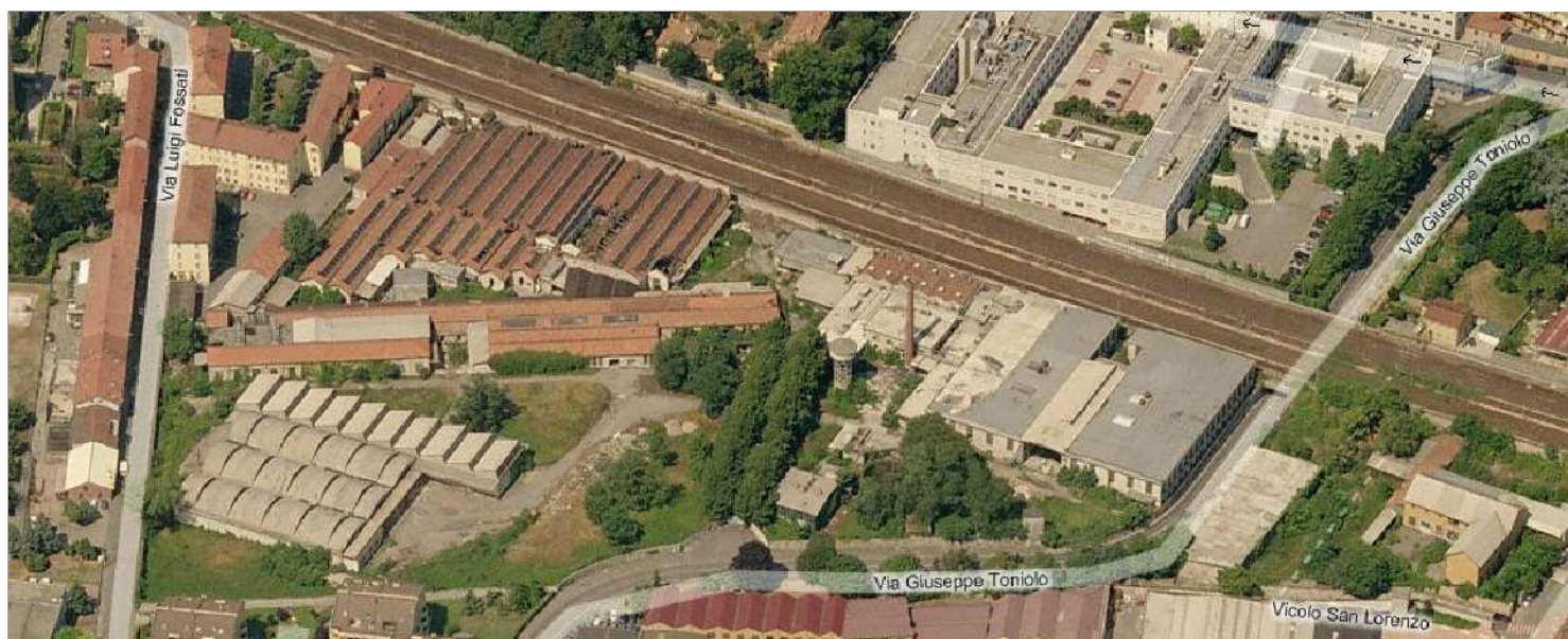
vista da est verso ovest
