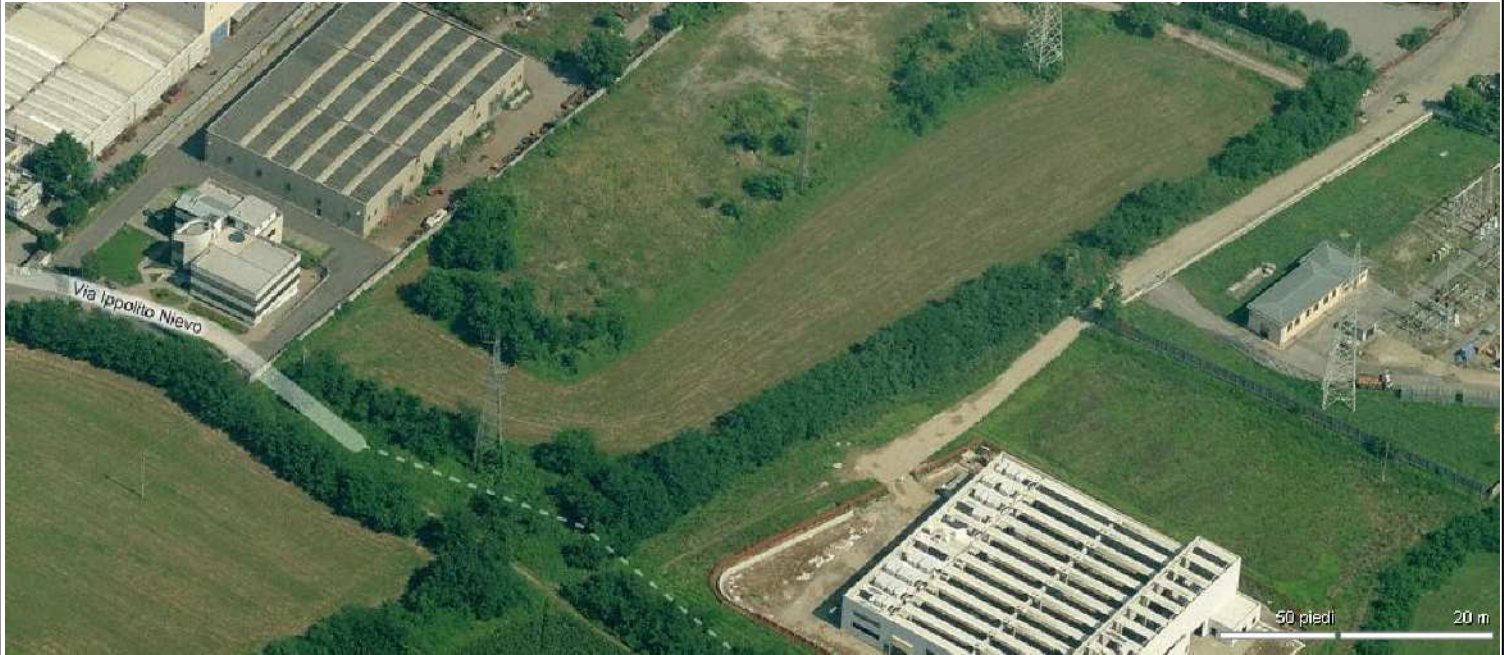
vista da sud verso nord
