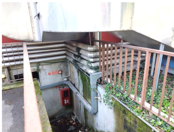
Vista delle tubazioni coibentate in FAV
