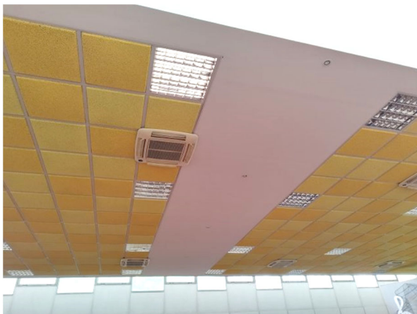
Vista dei pannelli di controsoffitto in FAV
