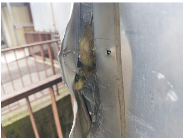
Vista particolare della coibentazione di canali in FAV
