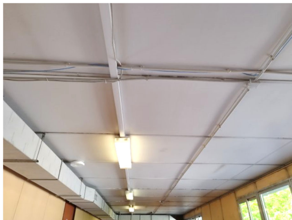
Vista del controsoffitto in cemento-amianto coibentato con materassino in FAV
