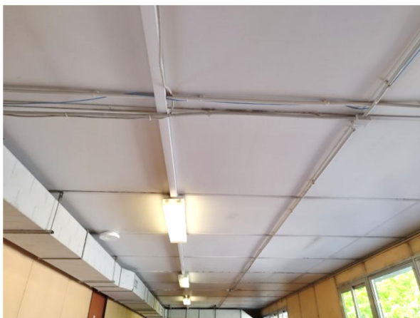
Vista del controsoffitto modulare
