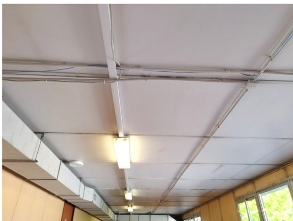
Vista del controsoffitto modulare
