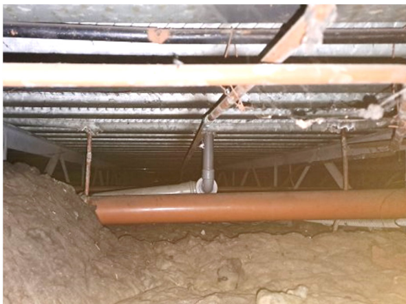
Vista del materassino di coibentazione in FAV al di sopra del controsoffitto in cemento-amianto
