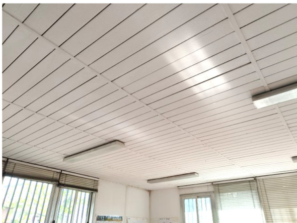
Vista del controsoffitto in doghe metalliche coibentato con materassino in FAV
