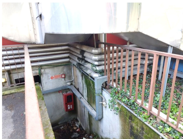
Vista delle tubazioni coibentate in FAV
