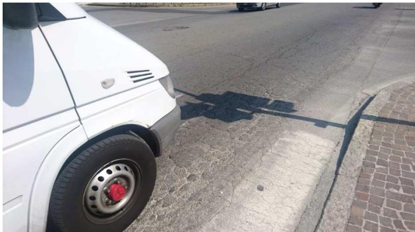
*Figura 14 – fessure a 'pelle di coccodrillo' in corrispondenza del transito delle ruote*
