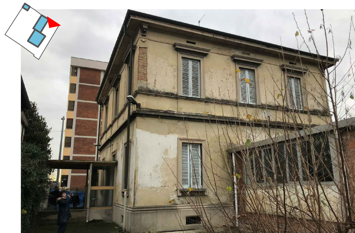
Facciata nord edificio principale e corpo basso
