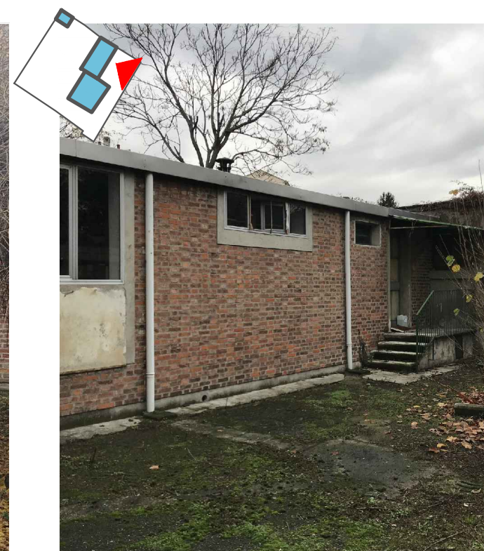
Facciata est corpo basso
