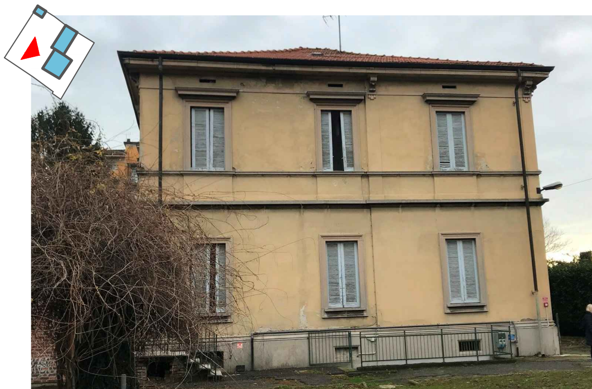
Facciata ovest edificio principale
