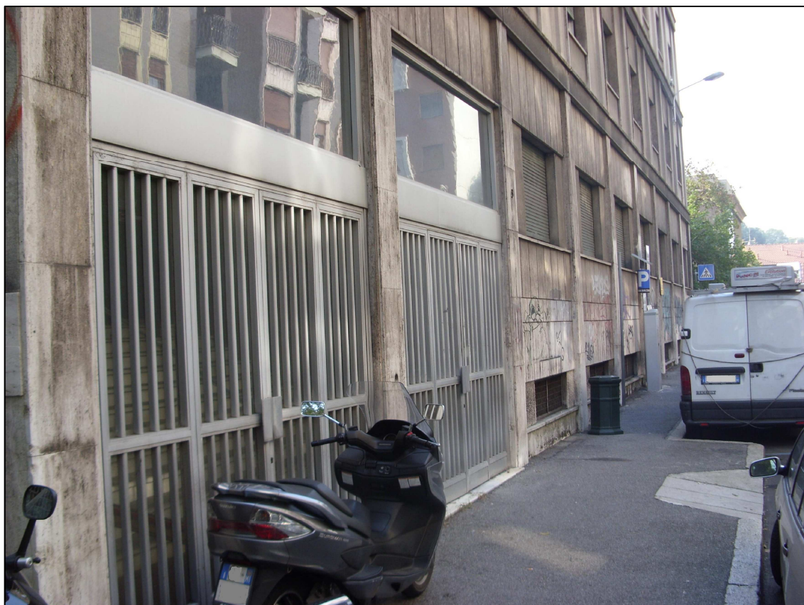
ingresso principale su via P. R. Giuliani
