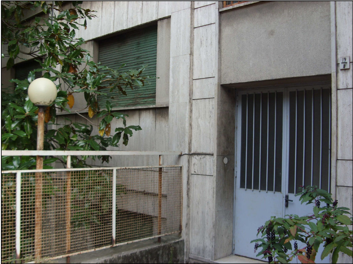
ingresso secondario su via Manzoni
