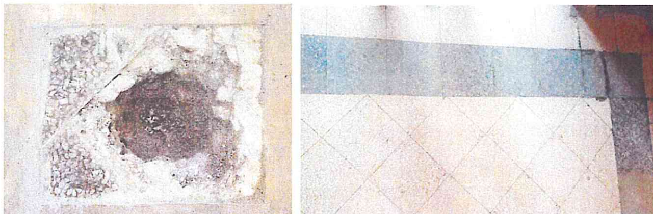
Fig. 23_Saggio stratigrafico delle pavimentazioni: (A sinistra) immagine del saggio effettuato con evidenziata la pavimentazione esistente (a destra) pavimentazione presente nei locali adiacenti e potenzialmente consimile con la pavimentazione esistente
