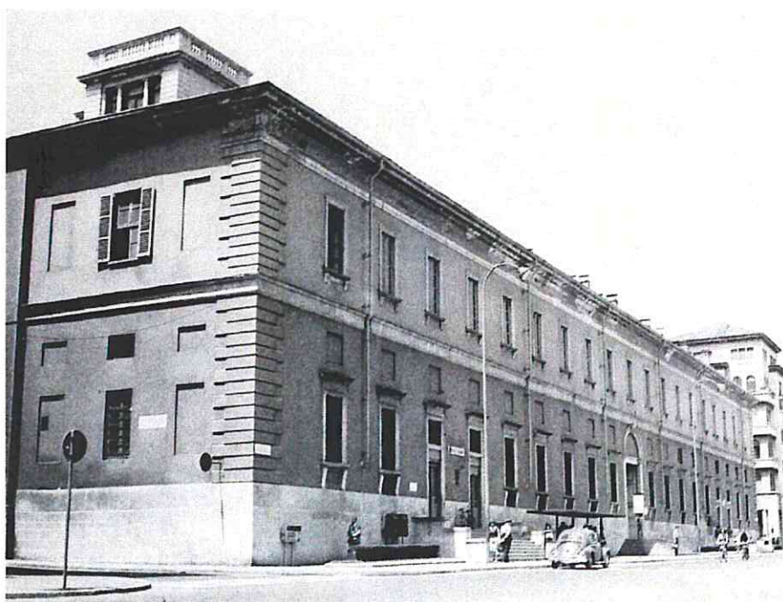
Fig. 19_Immagine del prospetto Est del Palazzo degli Studi con in primo piano l'ingresso dell'ufficio delle Poste.
